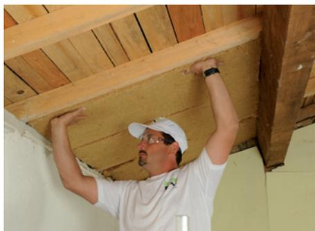
**Isonat Cottonwool** – textile recyclé – est un isolant bio-sourcé certifié ACERMI, jusqu'à un R de 12m<sup>2</sup> K/W. Il permet une
