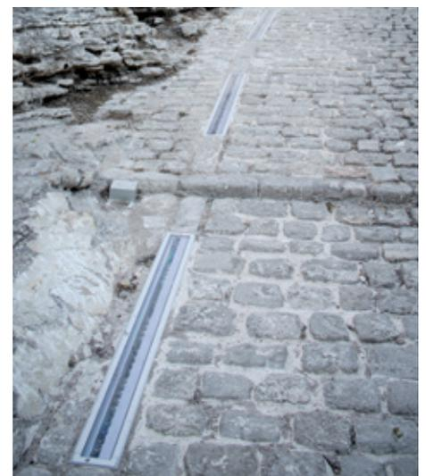
Afin de sécuriser la montée Saint-Roch, durant les accès de nuit à la citadelle, mais aussi pour rythmer les emmarchements, LEC et L'Agencelumière ont imaginé un système d'éclairage sur-mesure : une petite borne en aluminium, positionnée sur le côté intérieur de la montée, vient souligner d'un trait de lumière blanche sur chacune des marches.
