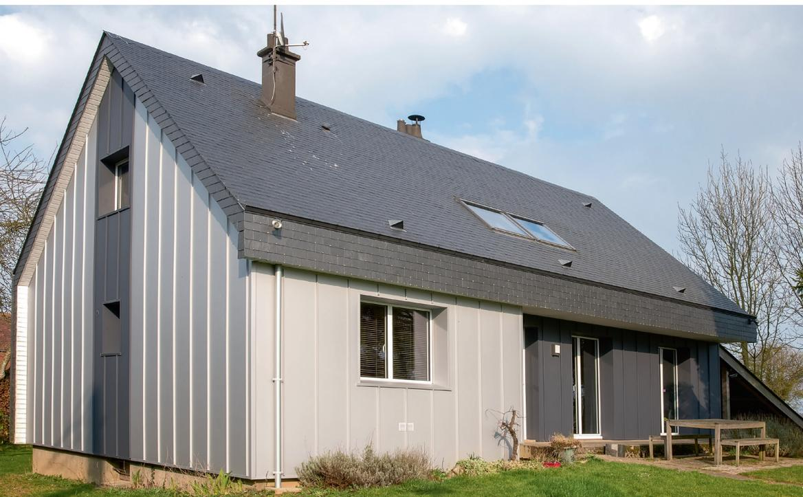
C'est une des finitions les plus tendances du moment dans le logement collectif et le tertiaire, et elle s'ouvre au marché de l'individuel. Le joint debout vient enrichir la gamme d'isolants par l'extérieur Uniso. Un système bien plus simple et performant thermiquement que la solution traditionnelle en zinc, mais un rendu très moderne qui permet de relooker totalement une maison. Plusieurs spécialistes en architecture ont déjà été séduits.
