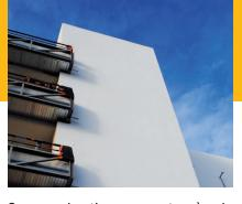
Sur ce chantier, ce sont près de 36 350 panneaux de Multipor qui ont été utilisés, et plus précisément des blocs YTONG de 16 cm d'épaisseur avec un R de 3,55 m².K/W et de 20 cm avec un R de 4,40 m².K/W.
