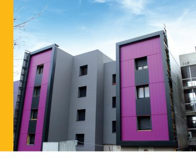
Ytong a contribué à la rénovation d'une caserne de Gendarmerie qui comprend 164 logements situés à Nantes. Pour cet ouvrage, l'architecte a choisi le système d'Isolation Thermique par l'Extérieur Keim XPor®. Ce procédé associe des composants 100 % minéraux sans fibres ni COV: les panneaux isolants Multipor de la gamme Ytong et une finition minérale (enduit et peinture Keim).
