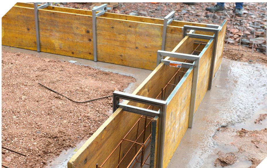
Inspiré par les chantiers, MACO a également été conçu pour accompagner les artisans maçons dans le respect des exigences du DTU (Document Technique Unifié), qui prévoit des contraintes spécifiques pour la construction d'ouvrages en béton armé.
