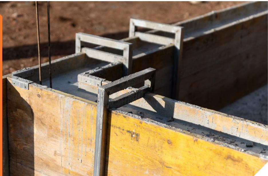
Sur le chantier, la réalisation des longrines s'accompagne de nombreuses contraintes pour les artisans. Préparation du terrain, installation du coffrage, ferraillage, coulage du béton puis décoffrage : les opérations s'enchaînent et les imprévus peuvent rapidement s'accumuler.
